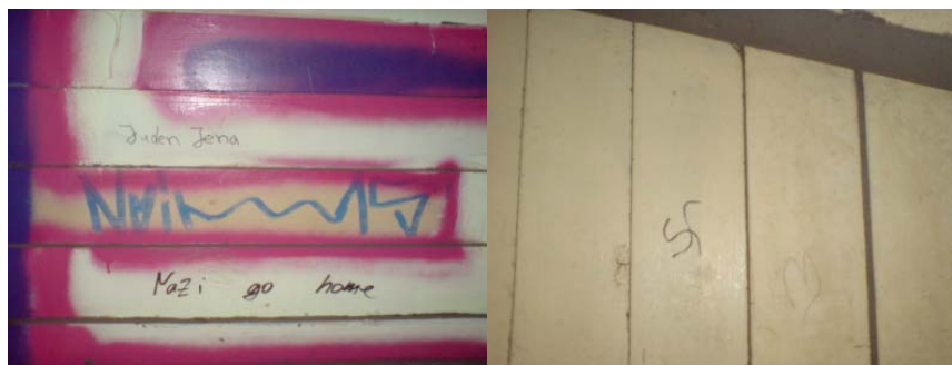
Abbildung 11 Aufnahmen am Bahnhof Apolda am 18.12.2011
